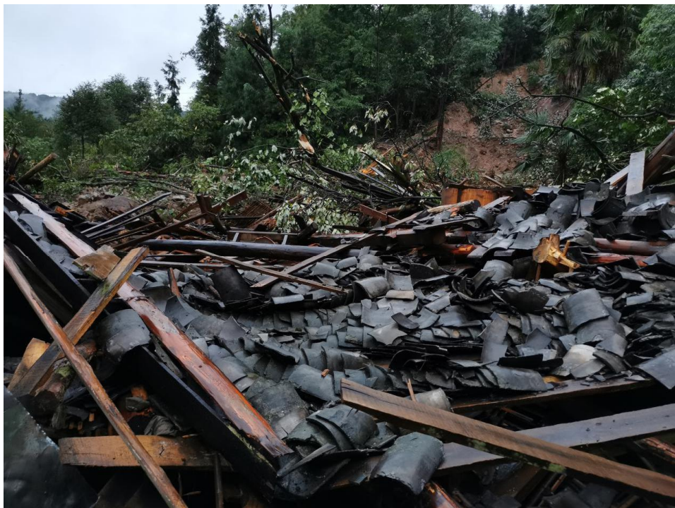
鲜湾村 4 组山体滑坡点房屋垮塌现场
